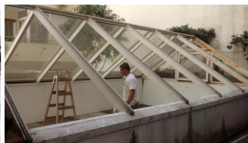
REEMPLAZO CUBIERTA POR ALUMINIO Y VIDRIO
