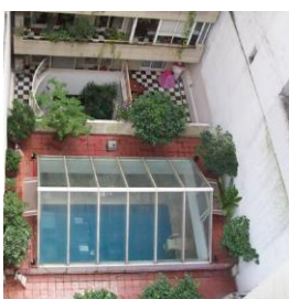
REEMPLAZO CUBIERTA POR ALUMINIO Y VIDRIO
