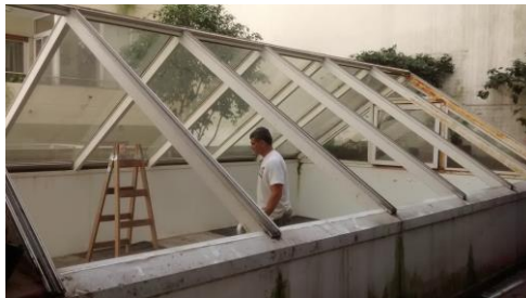
REEMPLAZO CUBIERTA POR ALUMINIO Y VIDRIO
